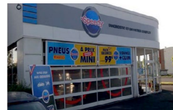
Après travaux, VINEUIL (41).
