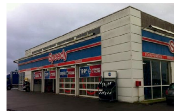
Avant travaux, VINEUIL (41).
